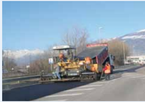
Ripristino sede viaria
