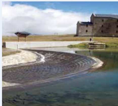
Diga di Miserin
